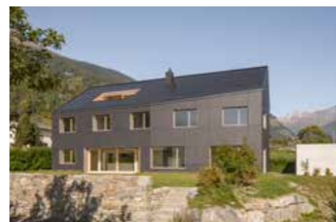
2. Preis Winter-Plusenergiehaus Sol'CH (2021), Poschiavo (CH) Nadia Vontobel Architekten GmbH, Zürich (CH)
