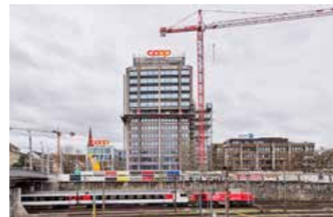
2. Preis Sanierung Coop-Hauptsitz TH12 (2021), Basel (CH) Burckhardt+Partner AG, Basel (CH)
