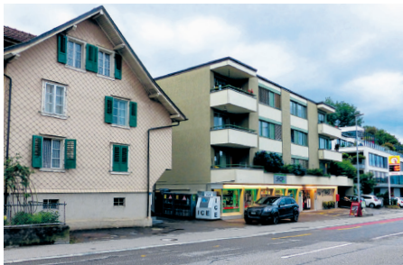
Ein Bild aus der Blütezeit des Blocks von Betli Stählin-Tschanz mit Tankstelle und Shop, die nicht mehr ersetzt werden – links die nun integrierte Liegenschaft Knobel.
