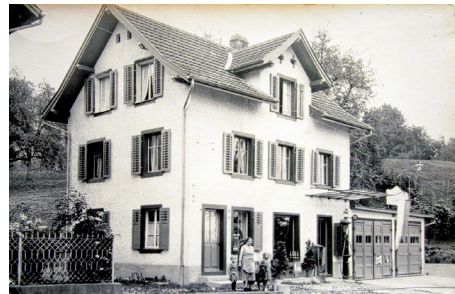
Vor dem 1975 erbauten Block stand das Haus der Familie Tschanz an dieser Stelle. Auf dem Bild ist Klein-Betli vor Werkstatt und Tankstelle zu erkennen.
